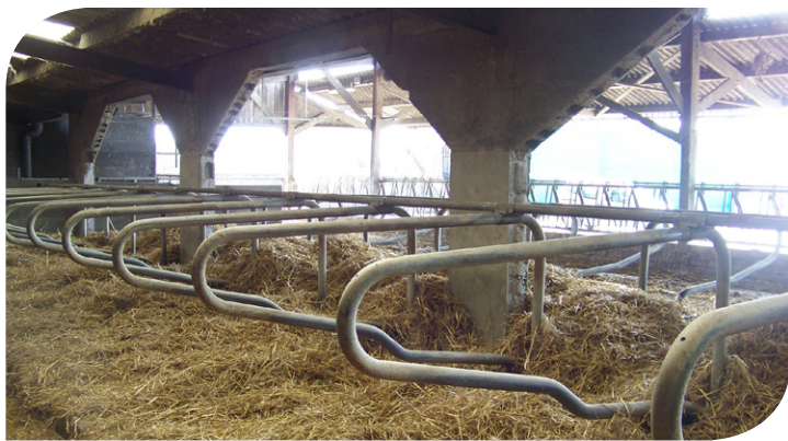
Après ouverture des murs entre les rangées de logettes, l'ambiance du bâtiment a changé, les vaches se reposent davantage et leur rumen semble plus efficace.
