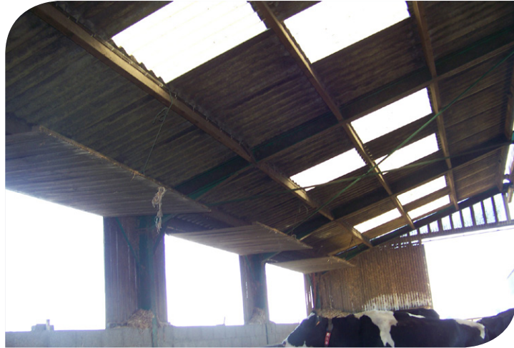
Des aménagements peu coûteux peuvent être faits dans les bâtiments laitiers pour aider les vaches à mieux supporter la période chaude d'été. Exemple : ces bardages amovibles.
